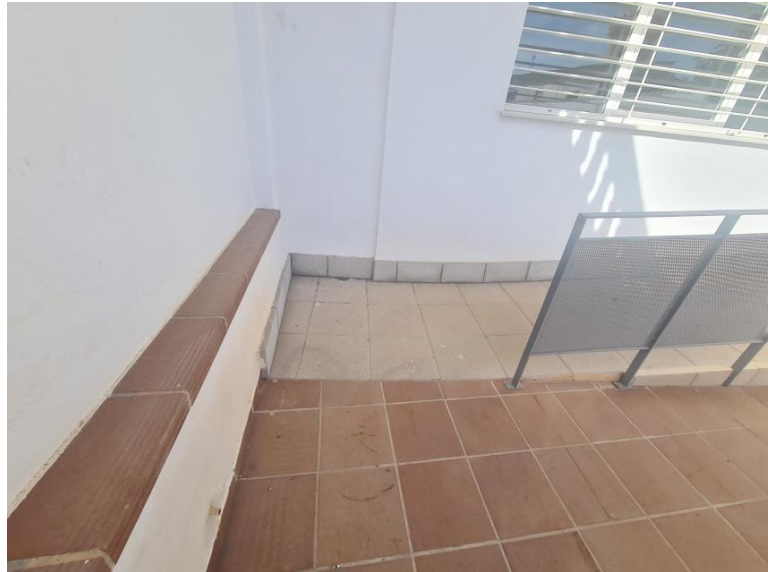
Meseta de giro con fondo 1,35m. inferior a los 1'50m. exigidos tras la rampa
