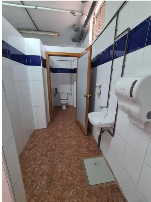
Aseo niños en planta baja a reformar
