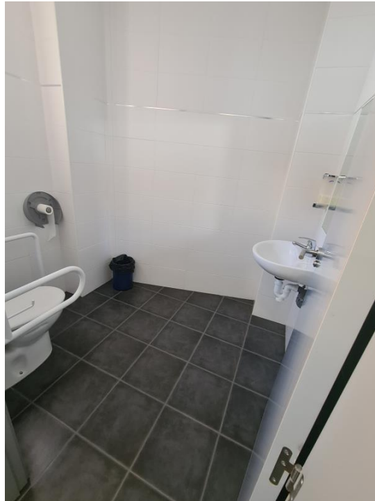
Aseo adaptado parcialmente en planta alta
