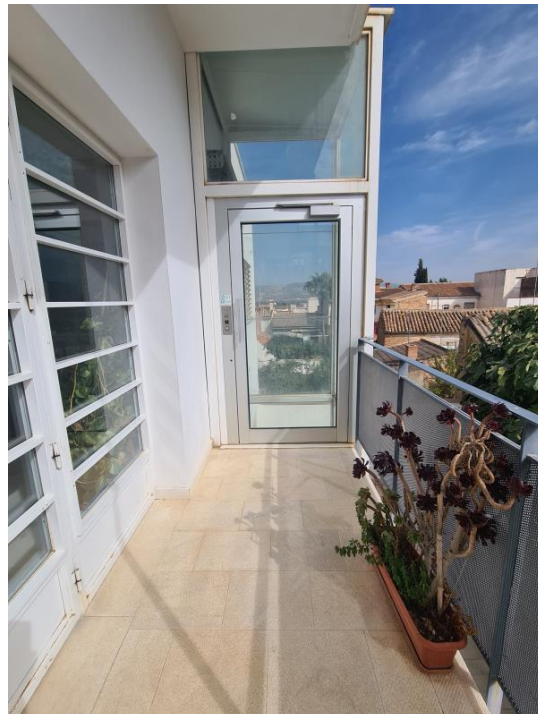
Pasillo exterior de la planta alta del Hogar del Pensionista
