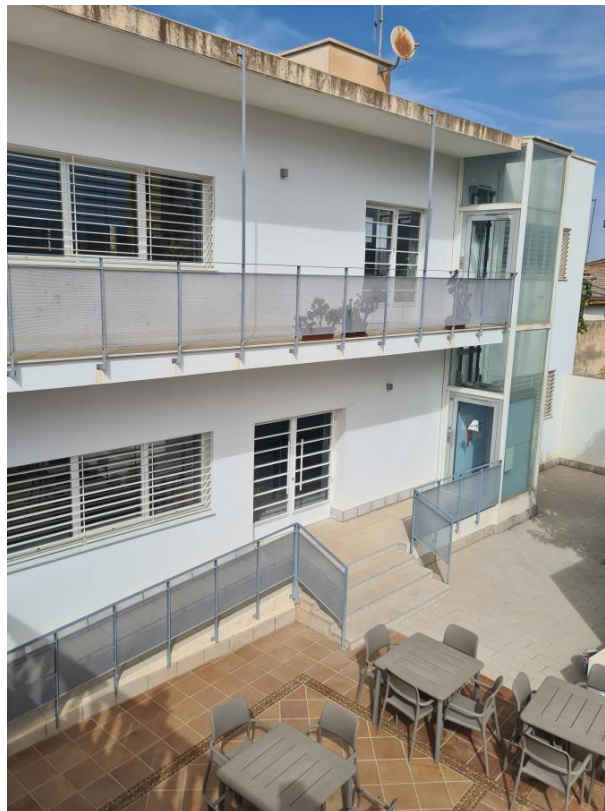
Vista del elevador que está dado de baja y los pasillos exteriores de acceso al edificio
