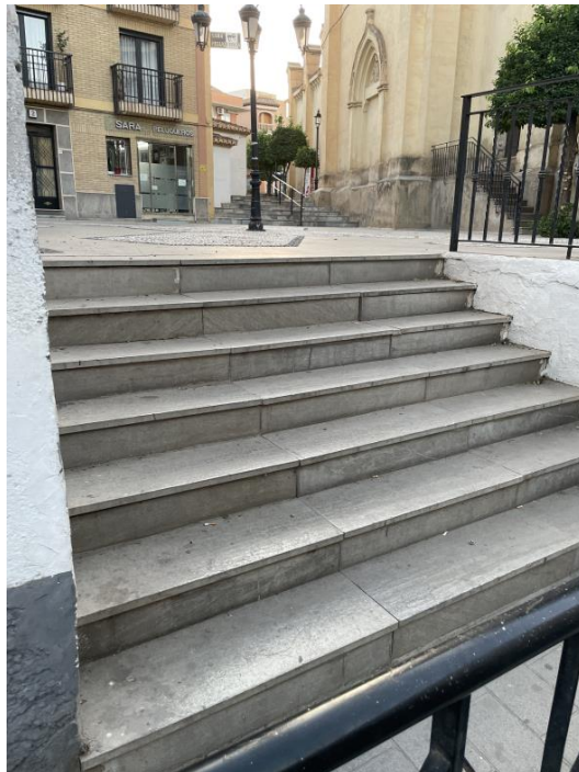
Vista de la escalera que da acceso desde la Calle Progreso a la Plaza de la Sacristía. Al fondo se ven las otras escaleras que van a la Plaza de la Iglesia
