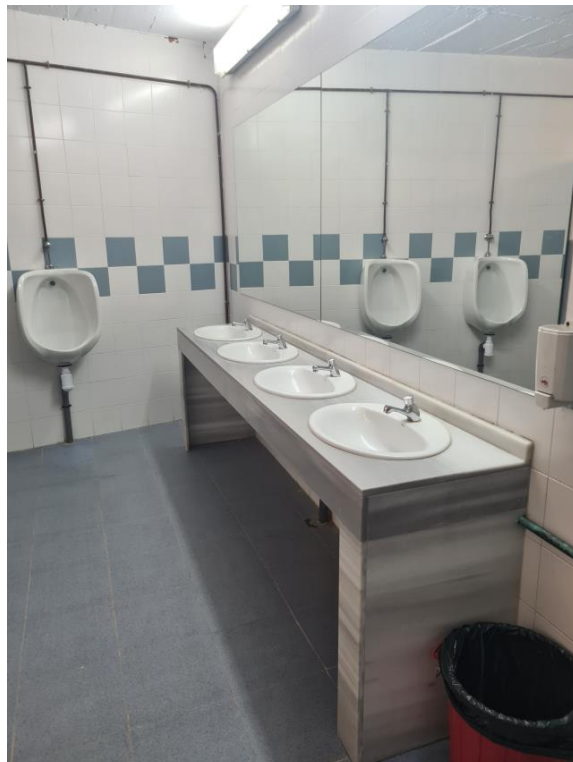
Núcleo de aseos para hombres en planta baja que se va a acondicionar
