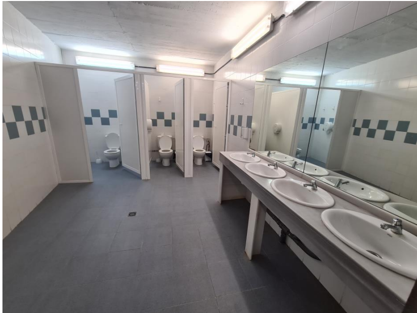
Núcleo de aseos para mujeres en planta baja que se va a acondicionar
