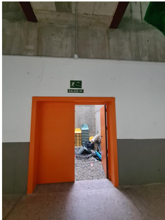
Patio exterior en planta sótano que se va a acondicionar a un aseo-vestuario-ducha accesible
