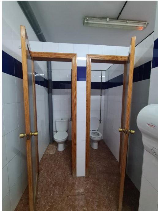
Aseo niñas en planta baja a reformar
