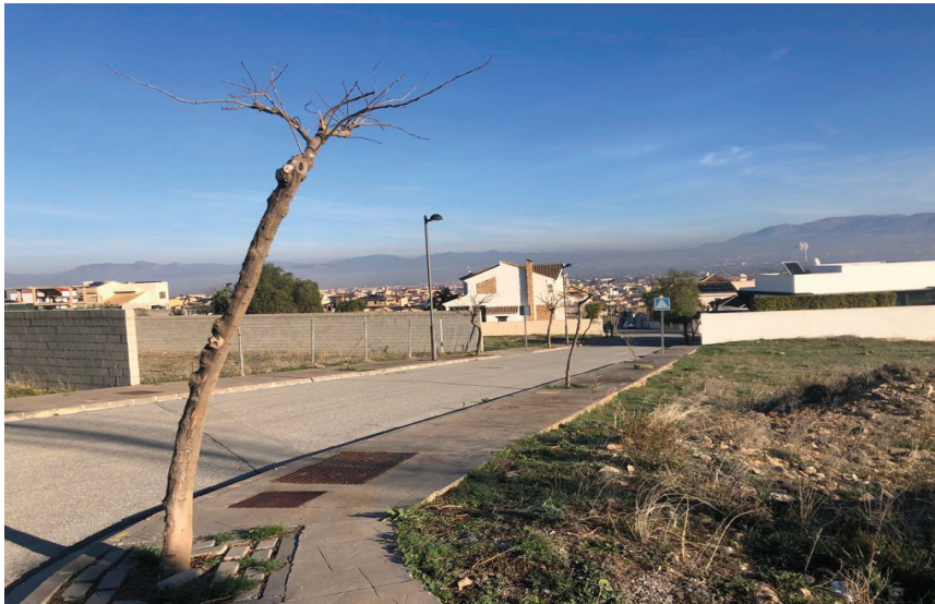
Imagen de cerramientos de parcela en viviendas construidas en la calle de la parcela
